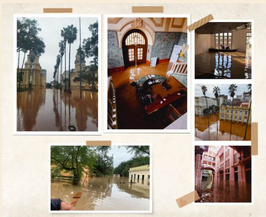
Figura 44. Instituições da SEDAC inundadas. Montagem feita pelo autor, 2025.
